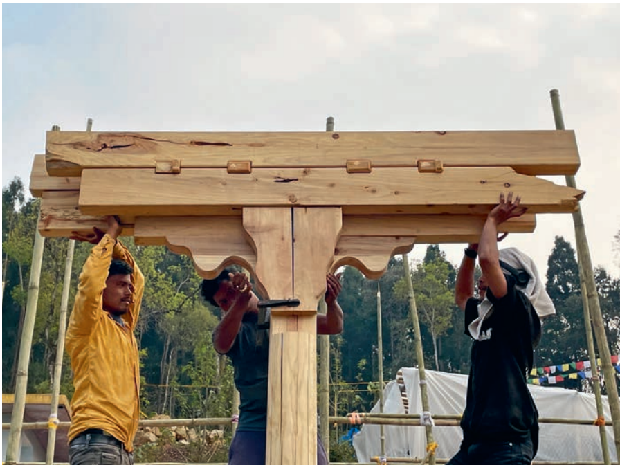
Das Mock-up eines verdübelten Mittelträgers aus Sichelanne im Massstab eins zu eins: Vor Ort werden Konstruktion, Holzverbindungen und Gestaltung getestet und weiterentwickelt.
