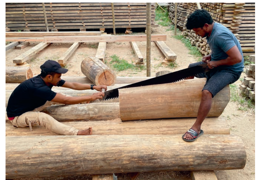
Die Ecksattelhölzer werden aus den Resten der dickeren Baumstämme in einem Stück skulpturiert. Das Eck wird von Hand aus dem Holzstück herausgesägt.
