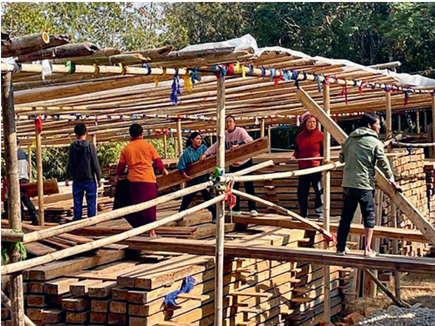
Die Gemeinschaft spielt beim Tempelbau eine grosse Rolle: Ortsansässige helfen, wo sie können, zum Beispiel bei der Lagerung des Holzes. Unter einer traditionellen Bambuskonstruktion lagert das Holz, bis es zur gewünschten Holzfeuchtigkeit getrocknet ist.
