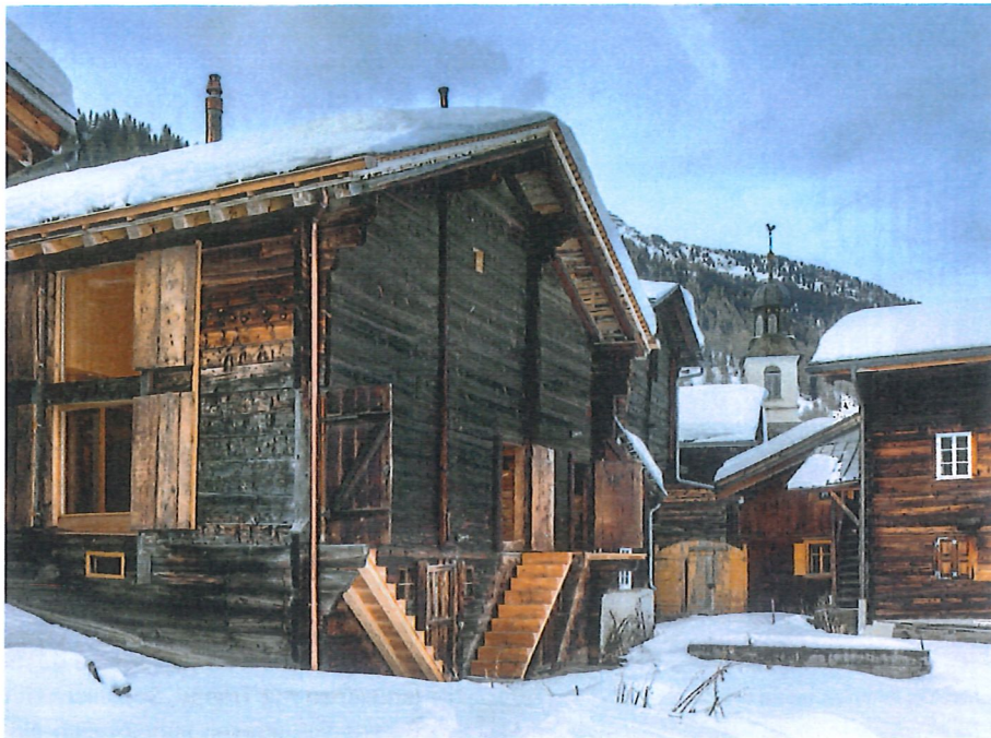
Die Stallscheune in Gluringen kaum verändert.
