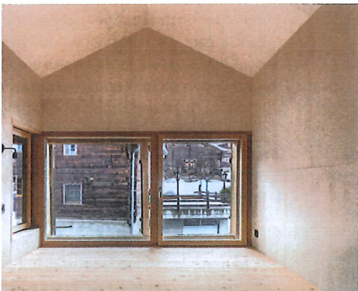
Wände und Decken sind durchgehend mit Sperrholz verkleidet.
