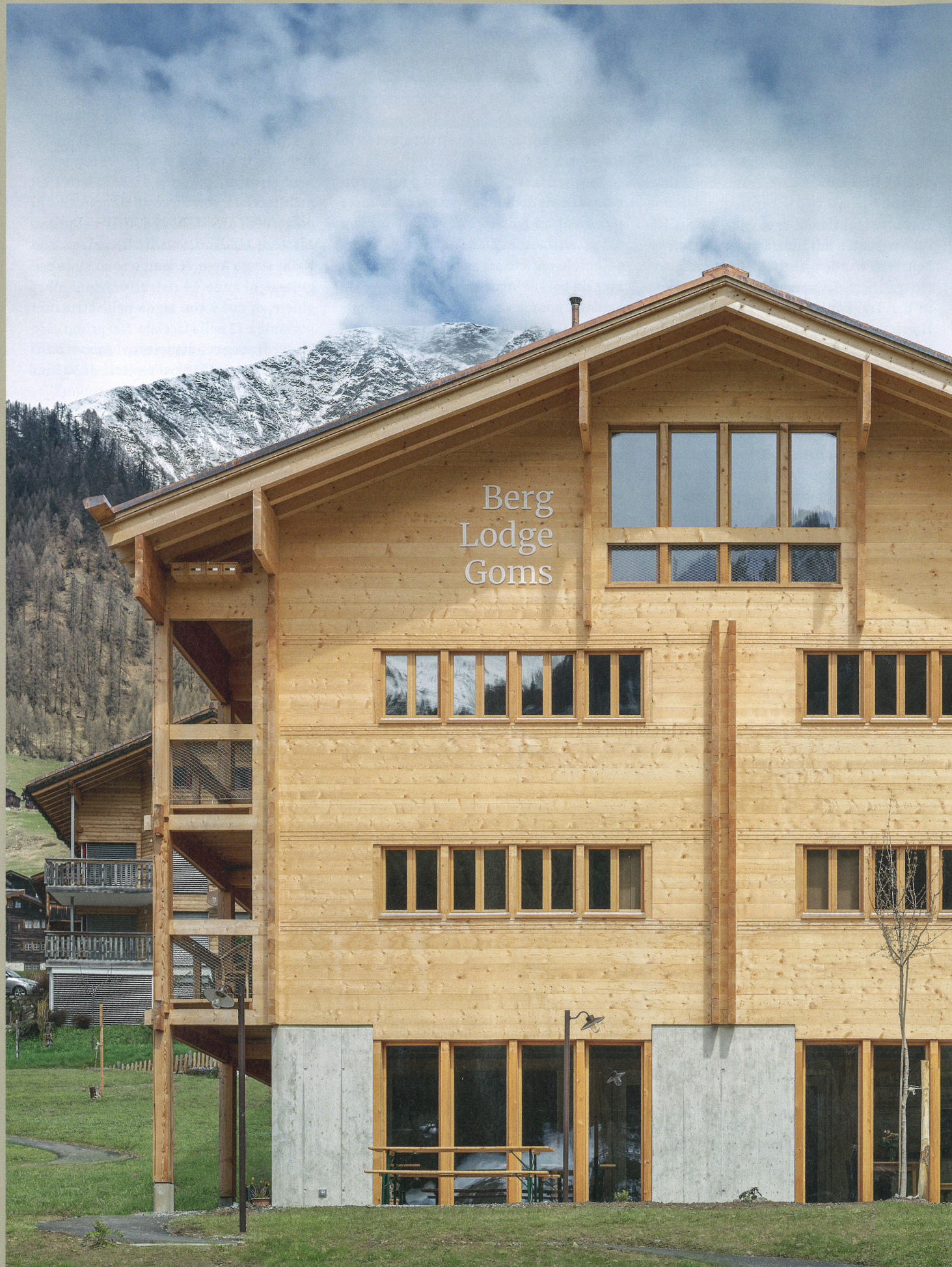
1 Die Blockwände der Berglodge sind aus Fichtenholz, die der Witterung ausgesetzte Fassade besteht aus massiver Lärche, der Sockel ist aus Beton. Les parois du Berglodge sont en épicéa, celles de la façade exposée aux intempéries en mélèze massif et le bâtiment s'appuie sur un socle en béton. Le pareti di tronchi del Berglodge sono in abete rosso, la facciata esposta alle intemperie in larice massiccio e l'edificio poggia su di uno zoccolo in calcestruzzo. FOTOS: MARKUS KÄCH
